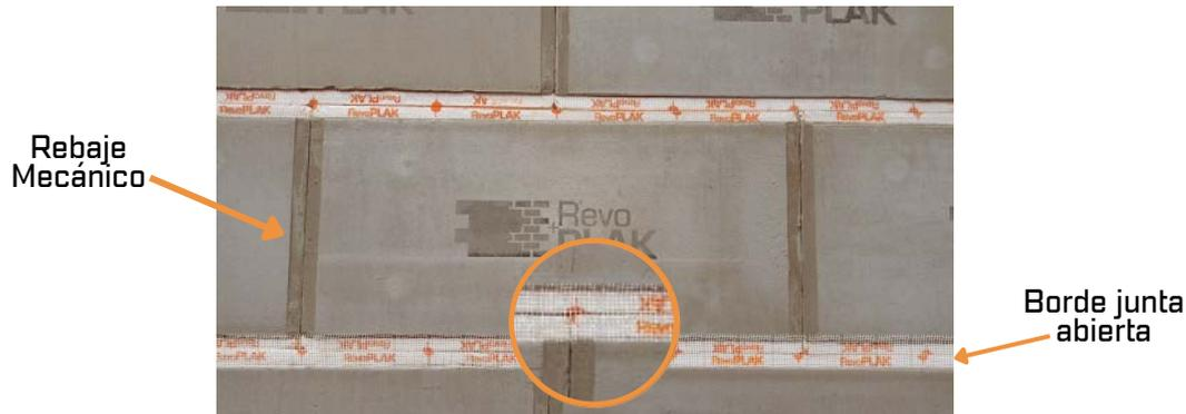
Recubrir las juntas con el espesor normalizado de base coat de fábrica.
