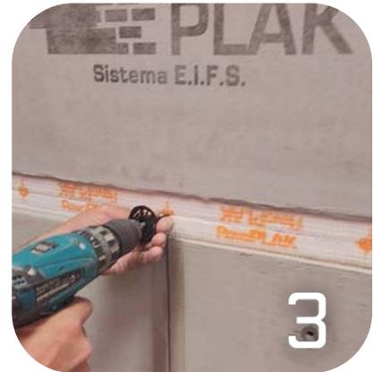
Cuando se requiera un nuevo punto de fijación sobre la superficie del revoque, se deberá proceder a realizar un fresado mecánico con fresa tipo "Forstner" o de desbaste frontal (50mm) hasta tomar contacto con la malla de fibra de vidrio, logrando así el alojamiento adecuado para la arandela tipo Washer.
